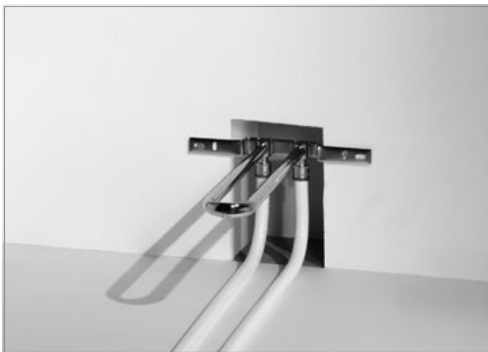
З'єднання радіатора з монтажним блоком радіатора — готове до випробування під тиском
