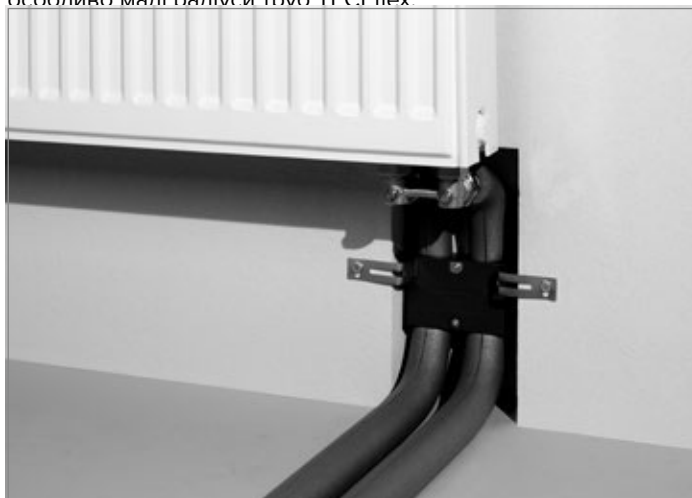
Підключення радіатора за допомогою монтажного модуля — підключення до блока клапанів
