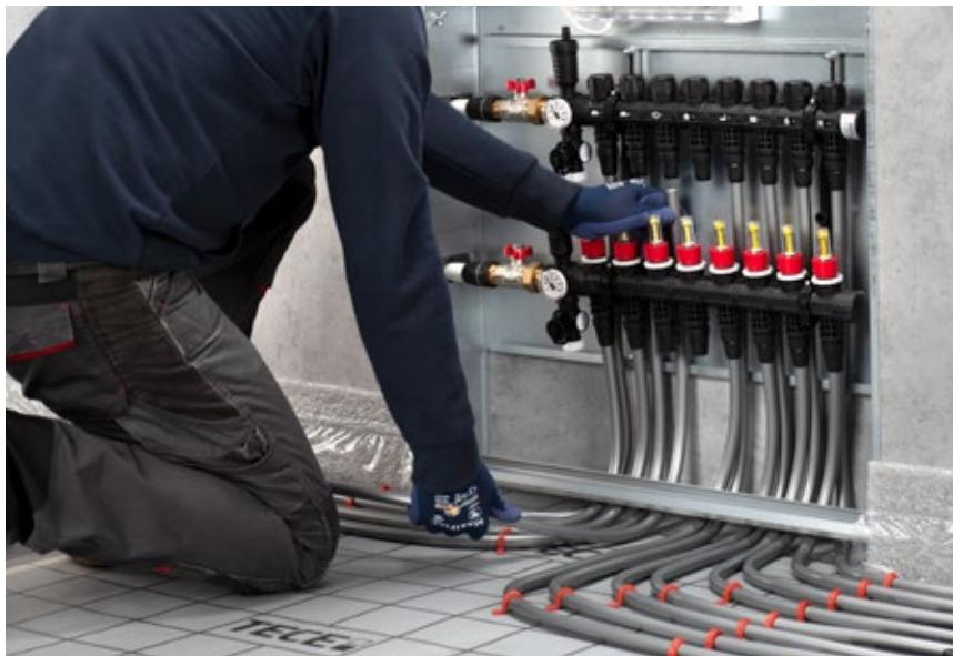
A diferencia de las conexiones roscadas convencionales, la conexión enchufable evita con fiabilidad problemas de instalación y cargas torsionales.
