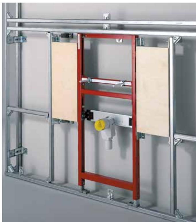
WT-Modul mit UP-Siphon, mit Halteplatten für Stützgriffe
