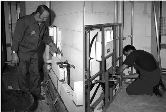
Nassbau (links) gegen Trockenbau
