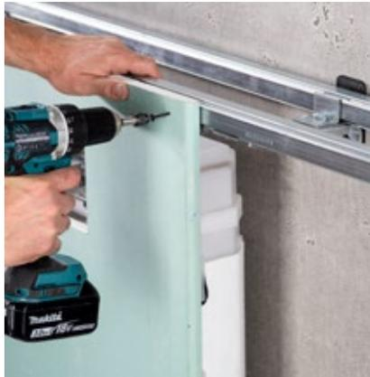
Montage der Gipskartonplatten mit selbstschneidenden Schrauben.
