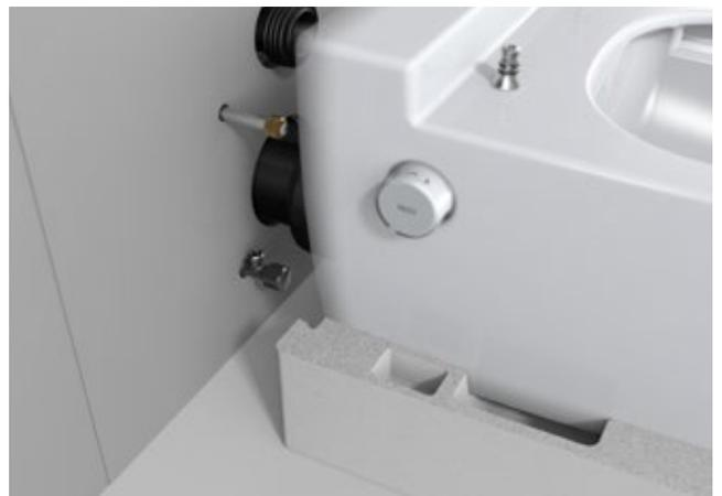
Rápida na parede: A TECEone é fornecida numa embalagem de fácil instalação. Para fixar, a TECEone desliza simplesmente para o lugar na sua embalagem, poupando as suas costas no processo.
