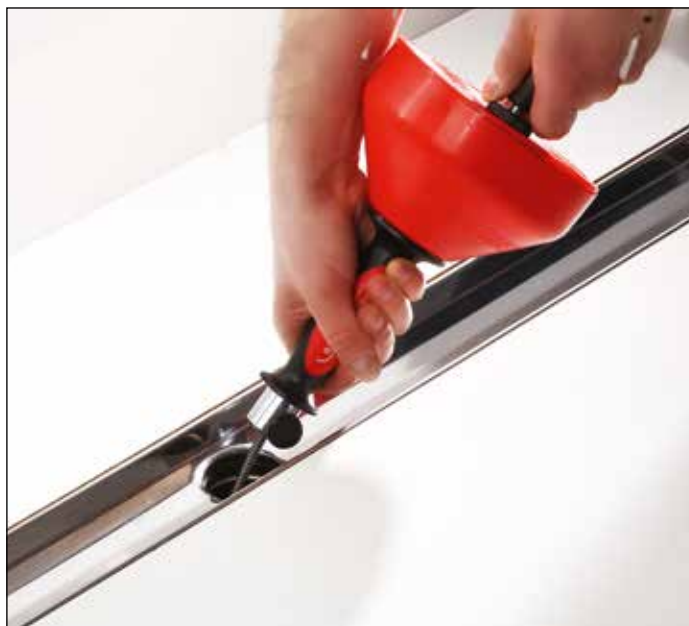
Abflussleitung mit kleiner Handspirale säubern
