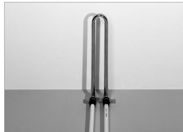
Heizkörperanschluss mit HK-Montagegarnitur, Bodenmontage – bereit zum Abdrücken
