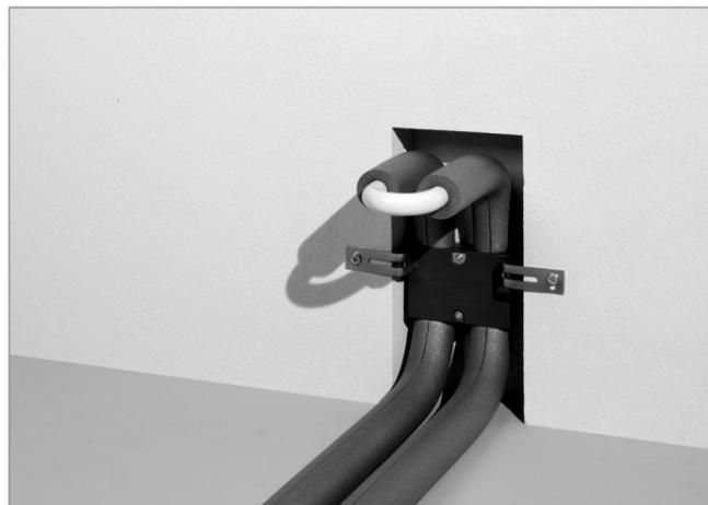
Heizkörperanschluss mit Montagemodul – bereit zum Abdrücken
