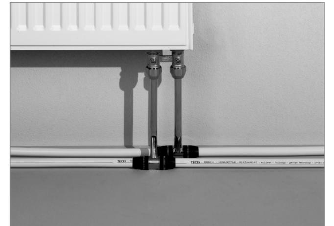
Heizkörperanschluss mit HK-Montage T-Stück
