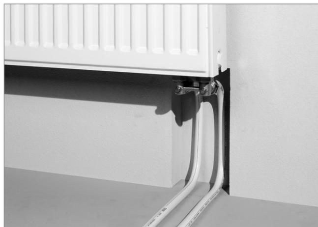
Heizkörperanschluss aus der Wand
