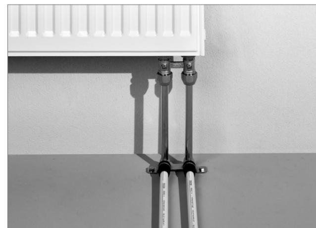
Heizkörperanschluss mit HK-Montagegarnitur, Bodenmontage – an den Hahnblock angeschlossen
