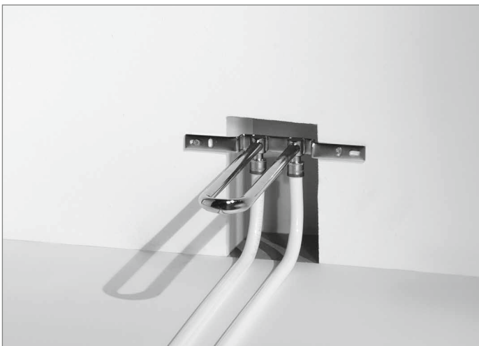
Heizkörperanschluss mit HK-Montagegarnitur – bereit zum Abdrücken
