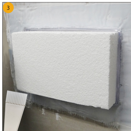
Safetybagen monteras med LIP Montagelim, som appliceras på underlaget med en fintandad limspredare (52 mm) för att minimera limrester utanför Safetybagen. Arbeta bort överflödigt lim, blåsor och kanaler (samma monteringsmetod gäller för spolröret).
