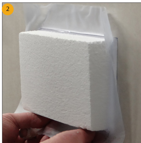
När plast flänsen dragits ut genom hålet för spolknapp och rengjorts monteras TECE medföljande kakelmall, som håller påsen på plats under montering.
