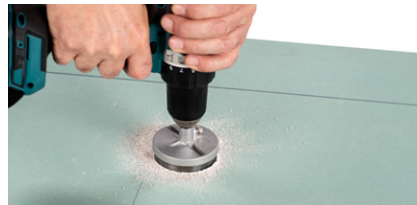
Шаг 2: Сверление отверстий.
