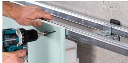
Шаг 3: Монтаж гипсокартонных листов саморезами.
