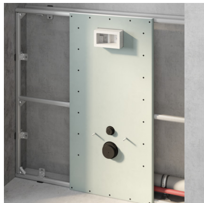
Шаг 2: Чтобы избежать стыков и переходов в области санитарных модулей, необходимо установить первые целые листы.
