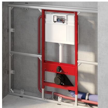
Шаг 1: После монтажа и гидравлического испытания каркас готов к обшивке.
