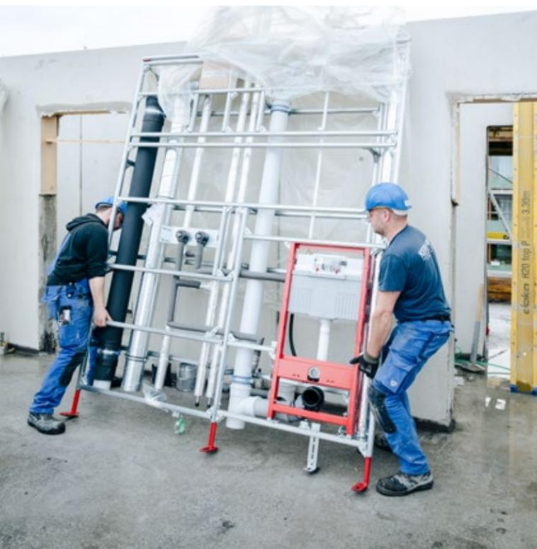
Gebaut wie geplant: Wird die Vorfertigung frühzeitig berücksichtigt, können die vorgefertigten Installationswände bereits im Rohbau per Kran auf die Etagen gesetzt und installiert werden, bevor die nächste Geschossdecke gegossen wird.
