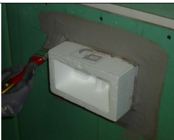
5c. Påfør omgående lag 2 etter at flensen er strøket på plass og glatt ut.
