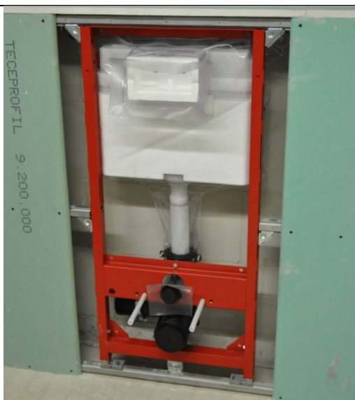
1. Installer WC-modulen i veggen.
