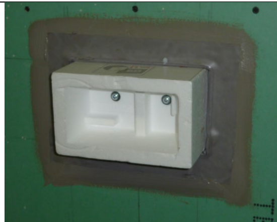
5b. Trykk flensen på plass i den fuktige smøremembranen og jevn ut, spesielt godt langs den innerste kanten.
