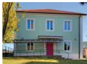
Scuola Primaria S. Stefano - La Spezia (IT) 330 m 2 di pannello in cartongesso a soffitto
