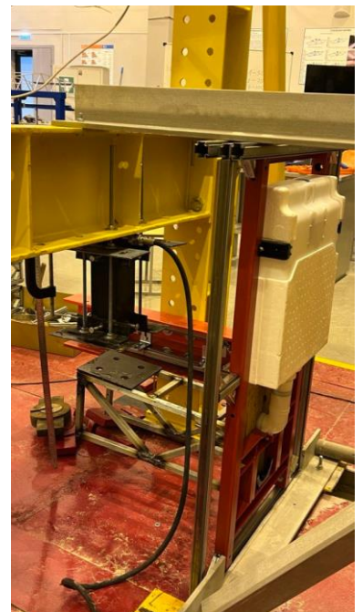
Рис. 3.43. Общий вид испытательного стенда системы скрытого монтажа унитаза
