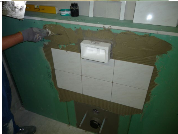
6a. Første trinn av flismontasjen
