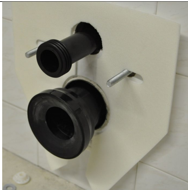
9. Etter at tettemassen har herdet, kan montasjen av porselent forberedes ved å sette skumplaten på plass. NB! Skumplaten skal monteres, da den sørger for dremsåpning i tillegg til støydemping.
