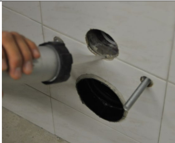
8c. Fyll rundt hele spalten mellom flisene og Sealingbagens kant med elastisk tettemasse
