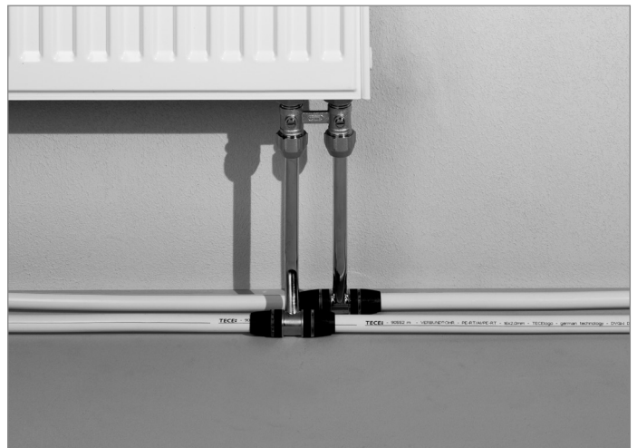
Heizkörperanschluss mit HK-Montage T-Stück
