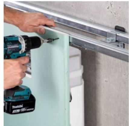
Montage der Gipskartonplatten mit selbstschneidenden Schrauben.
