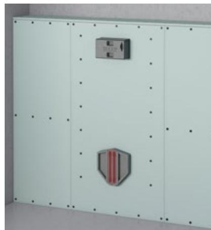
Daran schließt sich die weitere Beplankung an. Abschließend erfolgt die waagerechte Beplankung.
