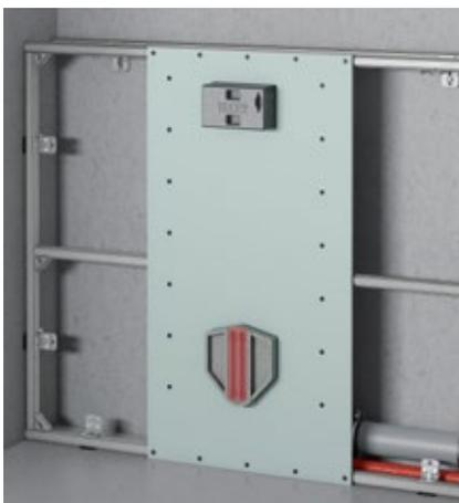
Um Plattenstöße/-übergänge im Bereich der Sanitärmodule zu vermeiden, sollten die ersten ganzen Platten in diesem Bereich montiert werden.
