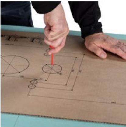
Anzeichnen der Löcher für die Beplanung des WC-Moduls per Bohrschablone, die sich auf jedem Modulkarton befindet.
