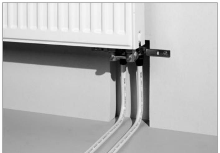
Conexión a radiador con unidad de montaje para radiador, montaje en pared, conectada al bloque de válvulas
