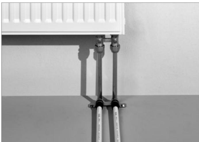
Conexión a radiador con unidad de montaje para radiador, montaje en suelo, conectada al bloque de válvulas
