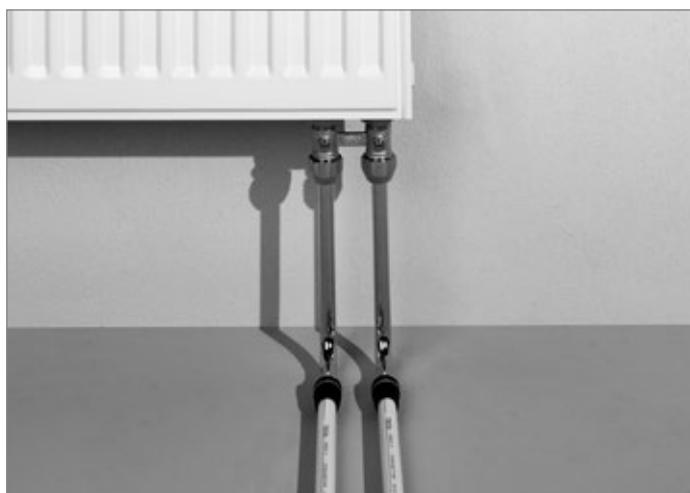
Conexión a radiador con codo de montaje para radiador
