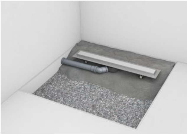
Schritt 2: Zur Gewährleistung eines optimalen Ablaufens wird der Estrich mit 1 bis 2 % Gefälle zur Rinne eingebracht.
