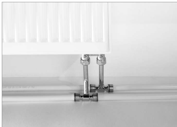
Radiatoraansluiting met montage-T-set aangesloten op het H-blok
