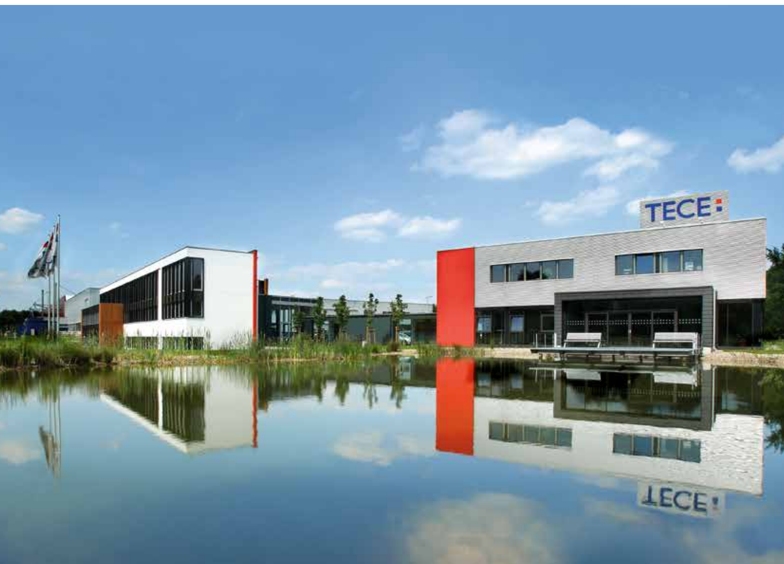
Siège de TECE avec centre de formation, Emsdetten
