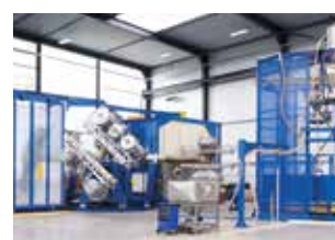
Installations rotatives pour les systèmes de dégraissage
