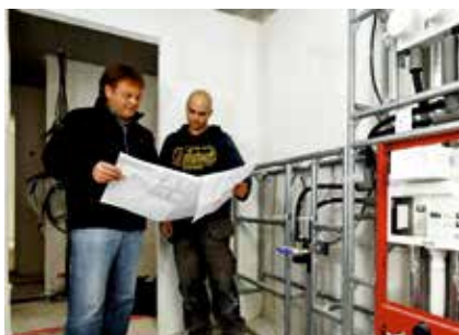
Instruction sur le chantier
