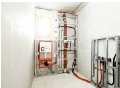
TECEsystem après installation
