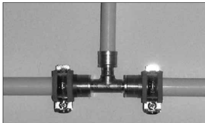
Wykonanie punktu stałego na trójniku
