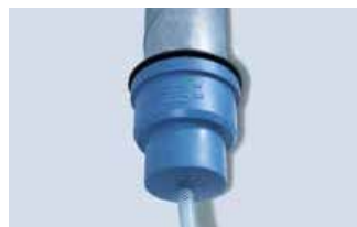
Закрепите элемент конденсатосборника на трубе
