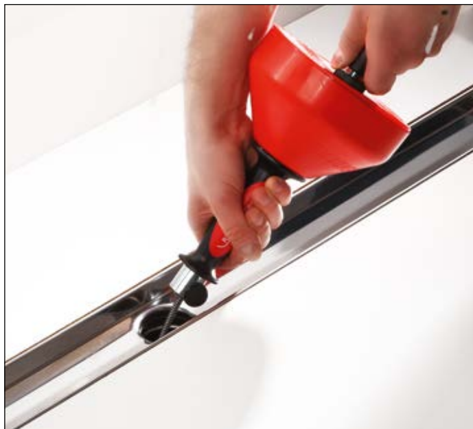
Сливную трубу прочищайте вручную с помощью небольшого троса для прочистки труб
