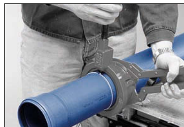
Kapning med kapnings- och fasningsapparat (FIGUR 19)
