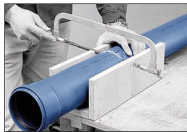
Kapning med fintandad såg (FIGUR 20)
