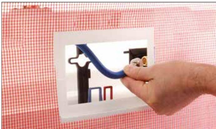
Присоединение шланга к заливному клапану бачка.
