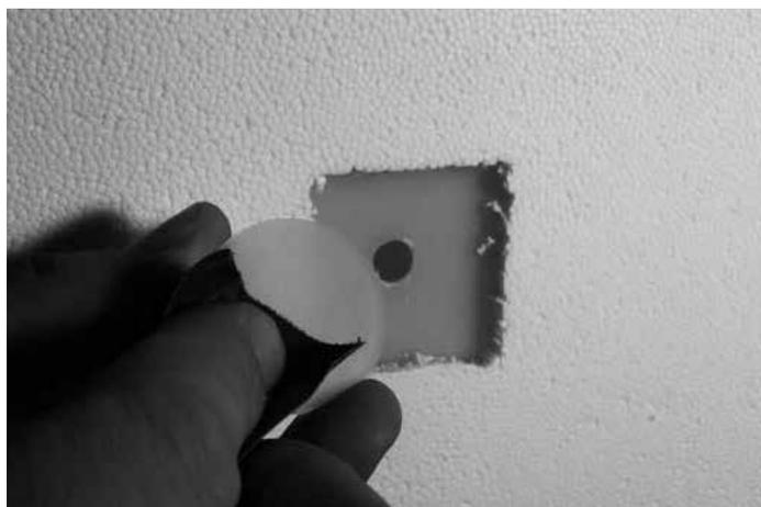
Тщательно протрите участок ремонта растворителем или ацетоном.
