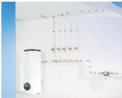
тронно-лучевым методом (PE-Xc). Слой EVOH (этиловинилалкоголь) выполняет антидиффузионные функции. Поверхность трубы серебристого цвета. Труба выпускается диаметрами 16 и 20 мм.
