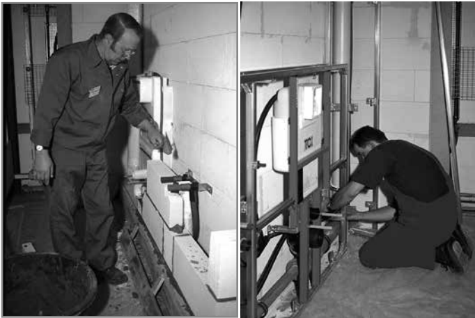
Nassbau (links) gegen Trockenbau
