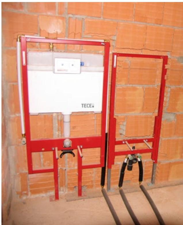
Innenwände in Italien sind meist nur 8 cm dick. Dafür ist ein spezieller Spülkasten mit geringer Einbautiefe und hohem Schallschutz erforderlich.
