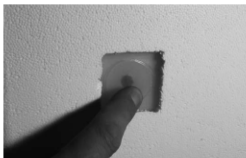
6. Tryck skivan över hålet och pressa med hårt tryck. Avvakta 15 min. Kontrollera därefter tätheten.
