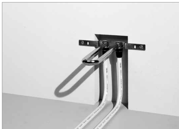
Heizkörperanschluss mit HK-Montagegarnitur, Wandmontage – bereit zum Abdrücken
