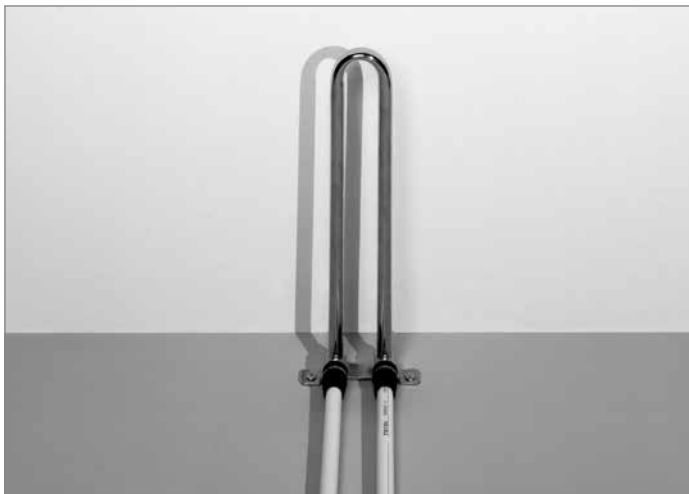
Heizkörperanschluss mit HK-Montagegarnitur, Bodenmontage – bereit zum Abdrücken
