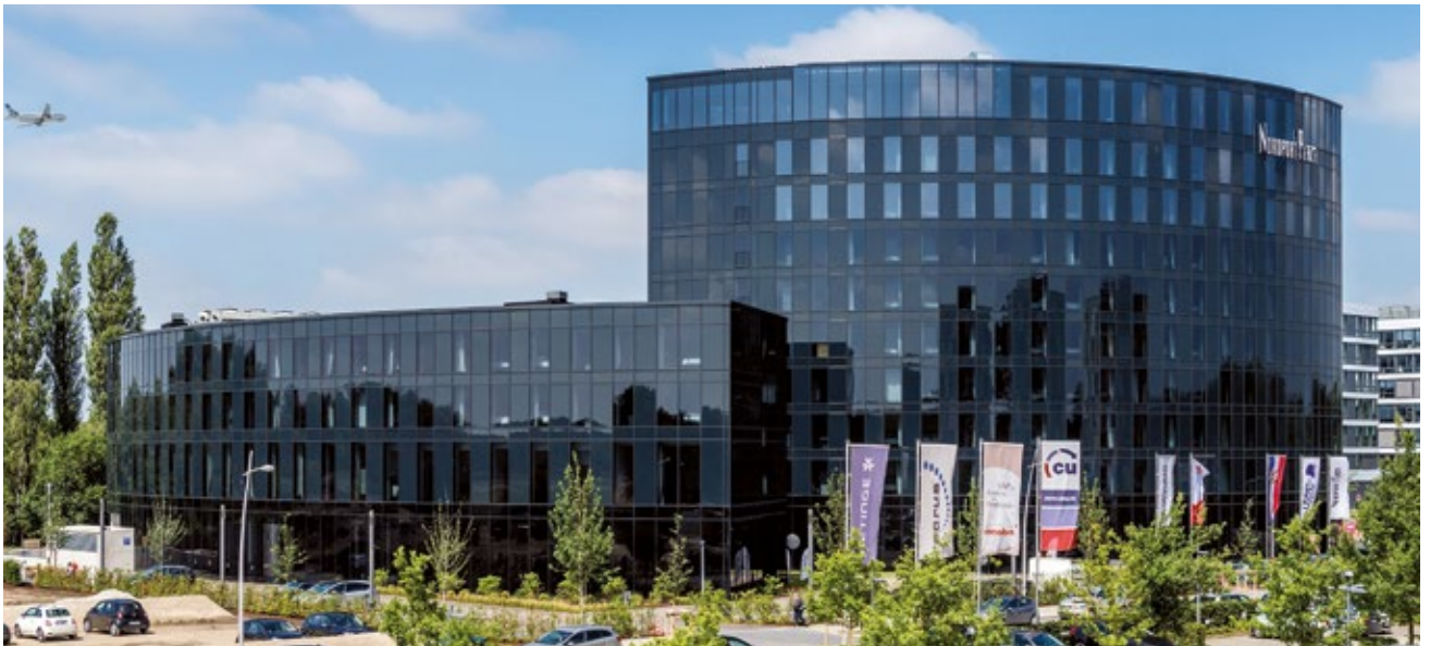
Foto: Nordport Plaza
