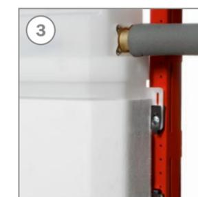
**Isolation acoustique** entre le boîtier de rinçage et le cadre du réservoir encastré.
