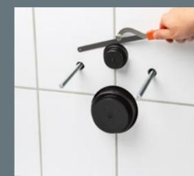
Les bouchons peuvent maintenant être coupés au même niveau que les carreaux avec une scie.
