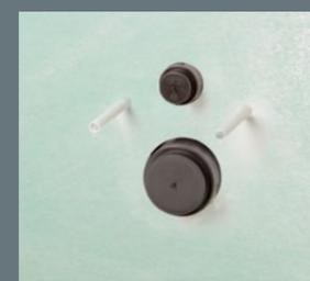
Les caches de la protection du gros œuvre sont faciles à placer sur le tube de rinçage et le coude d'évacuation.
