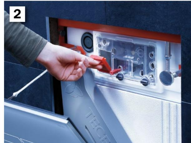
**2** Rabat ouvert : le conduit pour l'introduction des comprimés de nettoyant dans le réservoir encastré est parfaitement accessible.
