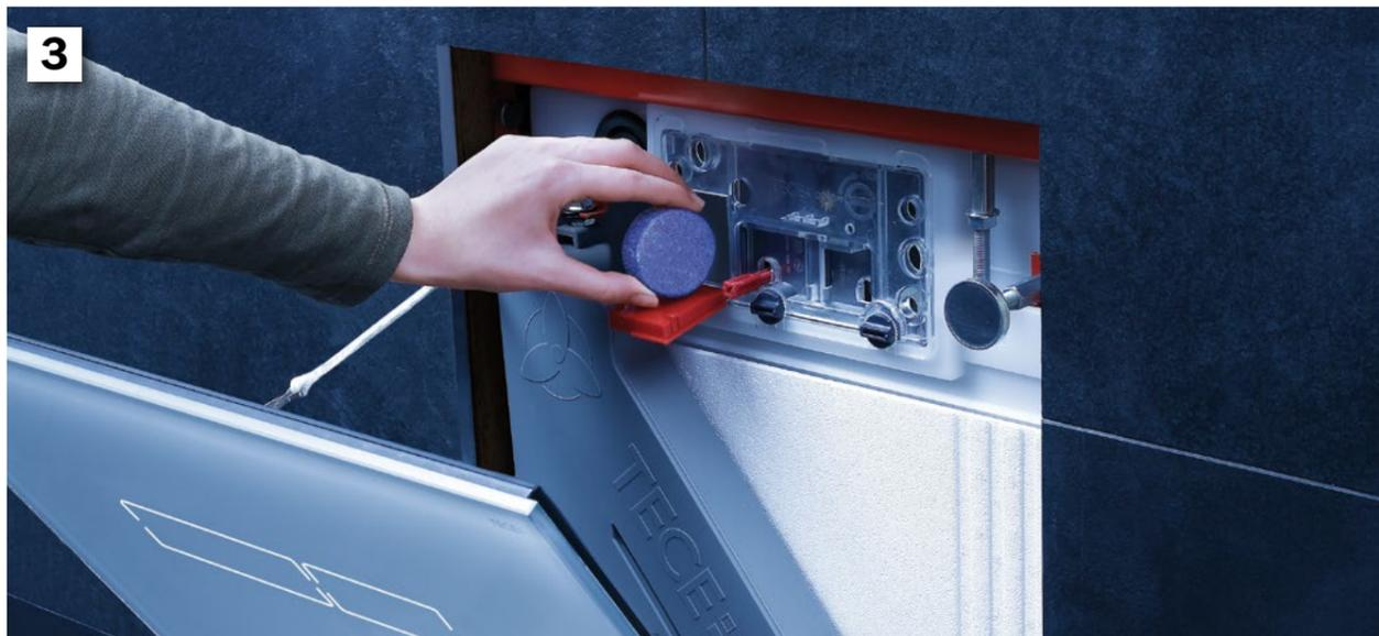
**3** Introduction : le comprimé de nettoyant tombe dans un bac d'où il diffuse ses substances actives dans l'eau du réservoir encastré.
