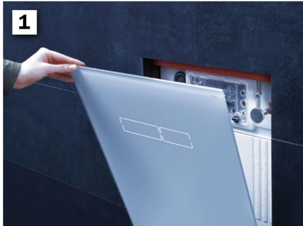
**1** Rapidement accessible : la plaque supérieure en verre est maintenue en place avec des aimants et peut aisément être rabattue.
