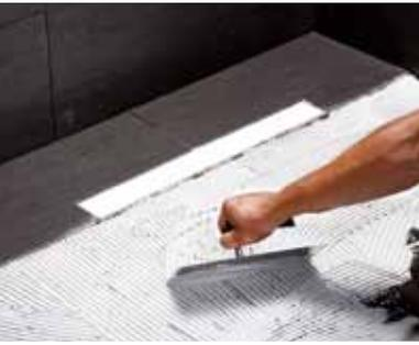
▲ **Irréaliste** : un coup de spatule crantée en travers de la colle à carrelage et les eaux d'infiltration sont bloquées.
