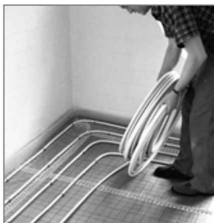
Укладка трубопровода
