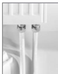
Подключение радиатора с использованием направляющего уголка
