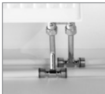
Подключение радиатора с использованием проходной трубки
