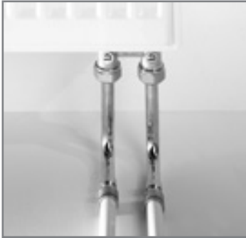
Подключение радиатора с использованием монтажной трубки
