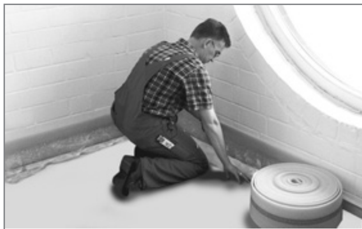
Укладка демпферной ленты
