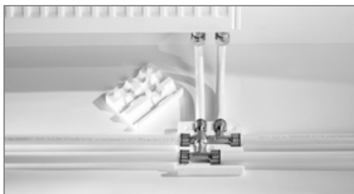
Подключение радиатора с использованием двойного тройника
