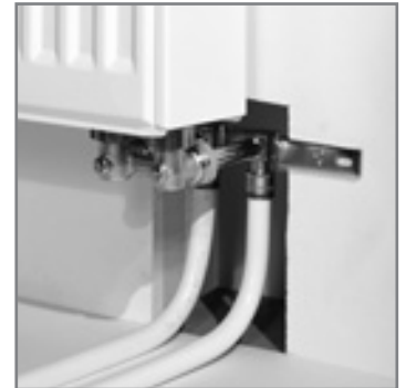
Подключение радиатора с использованием настенной монтажной планки
