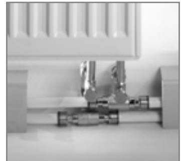
Подключение радиатора с использованием двойного тройника при плитусной проводке
