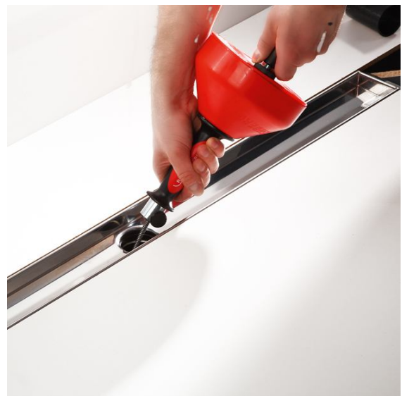
Odpadní potrubí čistěte pomocí malé manuální spirály
