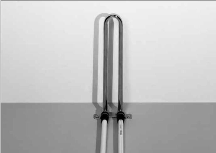
Heizkörperanschluss mit HK-Montagegarnitur, Bodenmontage – bereit zum Abdrücken
