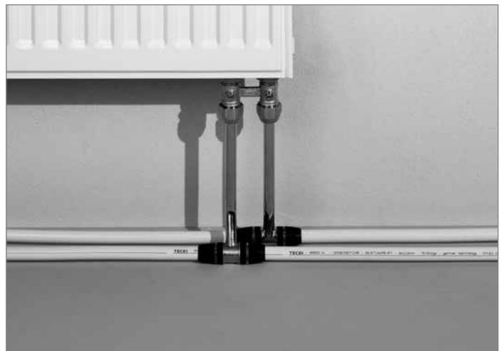
Heizkörperanschluss mit HK-Montage T-Stück
