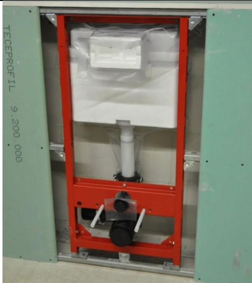
1. Installer WC-modulen i veggen.
