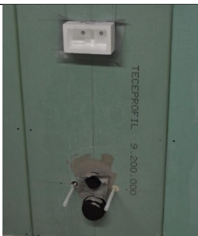
4. Påfør smøremembran på de aktuelle stedene.
