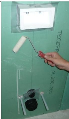
3. Påfør primer på frontplaten
