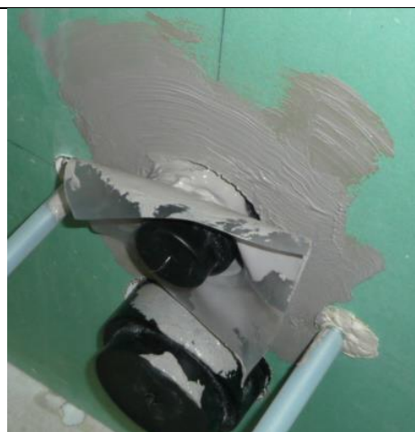
4a. Påfør membranen i stor omkrets rundt spylørøret
