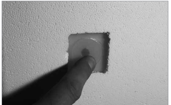
6. Placer le disque directement sur le réservoir et appuyer durant un court instant
