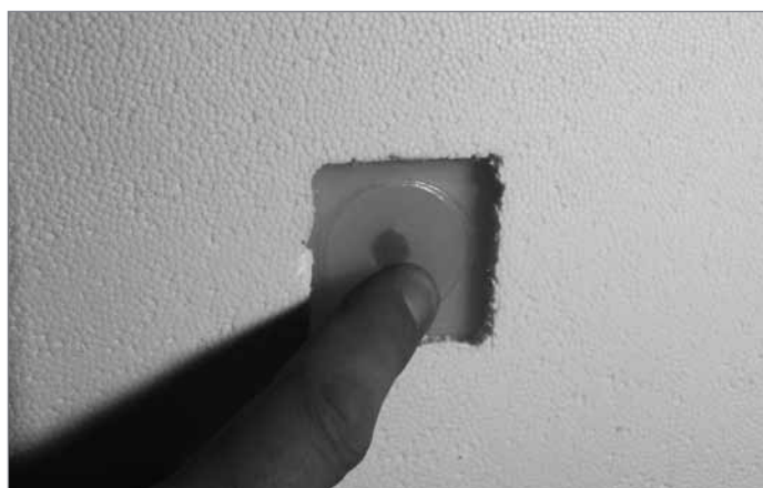
6. Przyłożyć plastikową płytkę bezpośrednio do spłuczki, docisnąć przez chwilę
