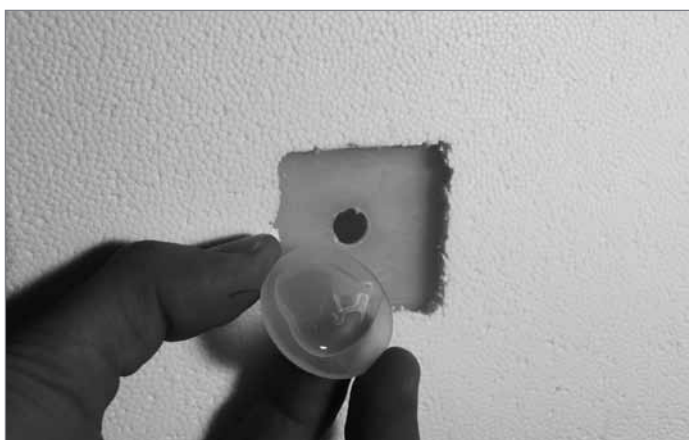
5. Нанести на пластиковый диск клей при помощи клеевого пистолета (область нанесения клея должна быть в два раза больше размера заклеиваемого отверстия). Используйте только оригинальный клей и не смешивайте его с другими клеями.
