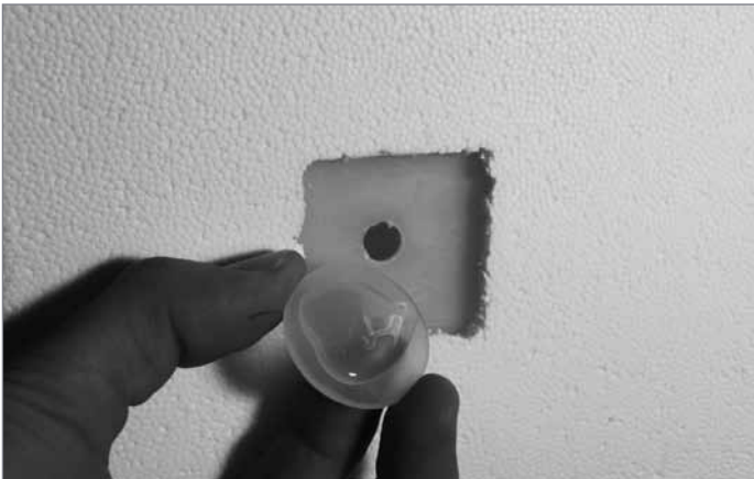
5. Enduire les 2 surfaces à coller avec la colle PP grâce au pistolet (2 fois la taille du trou). N'utiliser que la colle originale PP et ne pas mélanger avec une autre colle.
