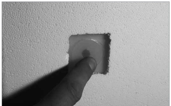
6. Sofort Kunststoffscheibe mit Klebeseite auf den Spülkasten aufsetzen und kurz andrücken
