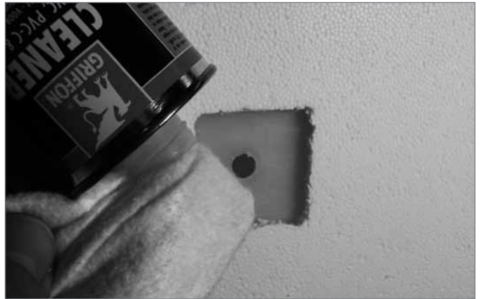
4. Nettoyer les surfaces à coller à l'acétone, ou avec le nettoyant fourni
