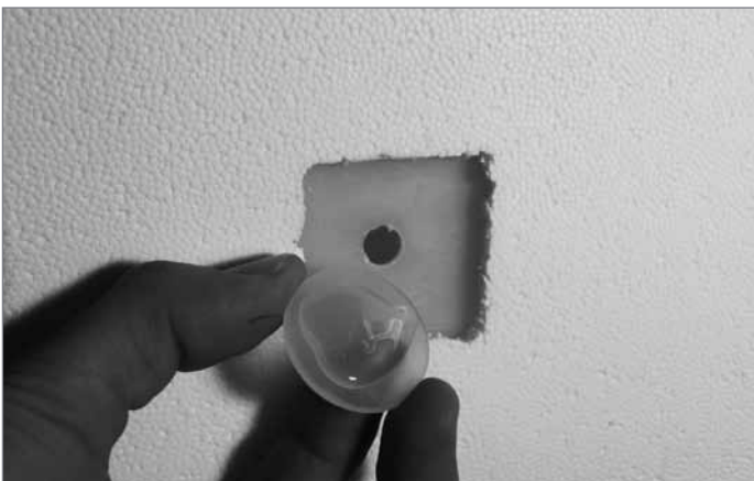
5. PP-Kleber mit Heißklebepistole auf die Kunststoffscheibe auftragen (2fache Lochgröße). Nur Original PP-Kleber benutzen, nicht mit anderem Kleber mischen!
