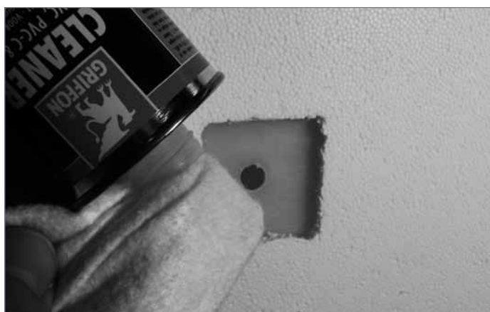
4. Pulire le zone da incollare con un solvente (anche acetone)
