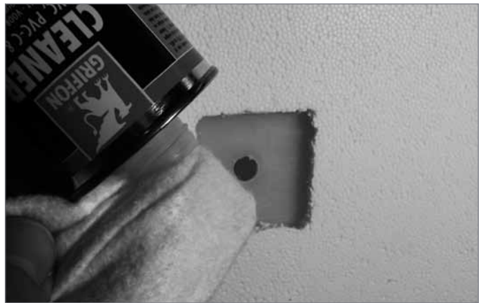
4. Beide Klebeflächen mit Aceton oder mitgeliefertem Cleaner reinigen
