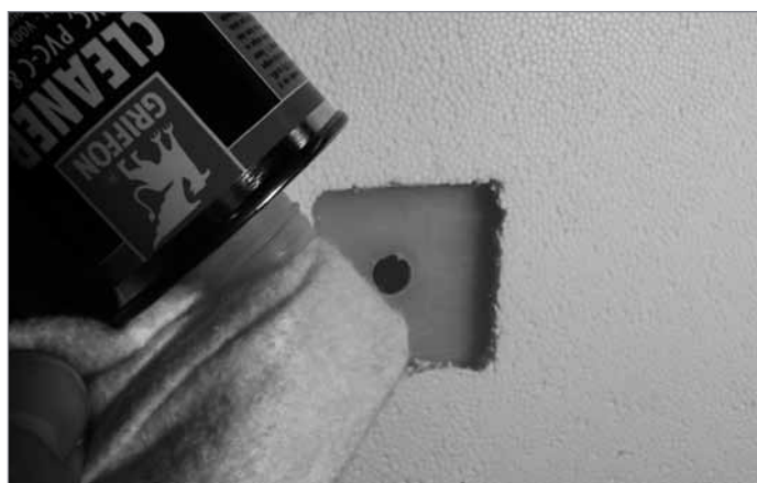
4. Wyczyścić powierzchnie klejące acetonem lub innym środkiem czyszczącym
