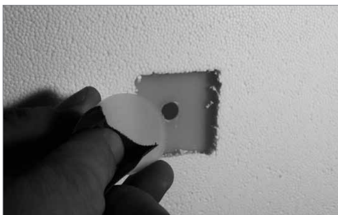
3. Przeszlifować obie powierzchnie klejące papierem ściernym
