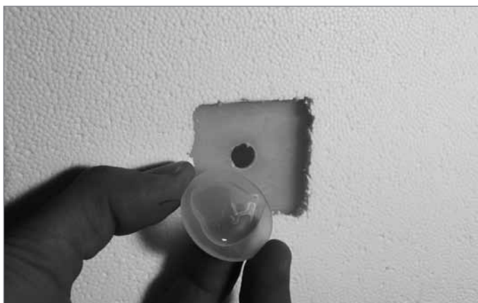
5. Inserire un bastoncino di colla nell'applicatore e spanderla sul dischetto (coprire una larghezza 2 volte superiore al diametro del foro). Utilizzare solo colla originale, non miscelare con altre colle!
