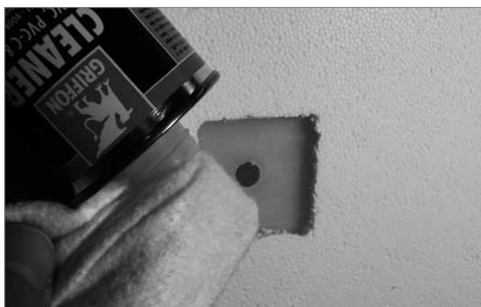
4. Очистить склеиваемые поверхности ацетоном или прилегающим очистителем
