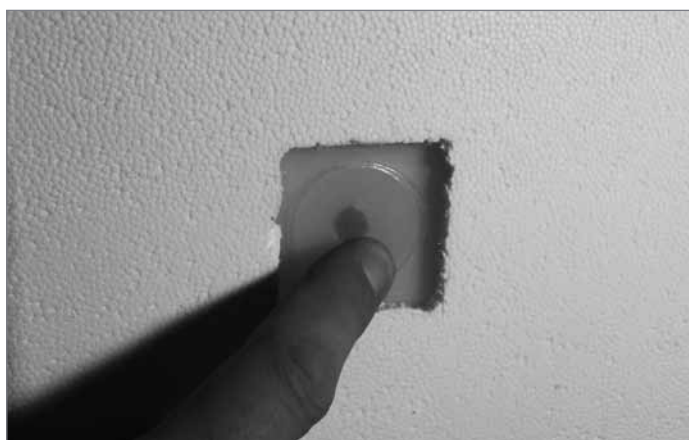
6. Прижмите пластиковый диск к багету на короткое время. 7. Время высыхания составляет примерно 15 минут, по истечении которых проверьте прочность приклеивания.
