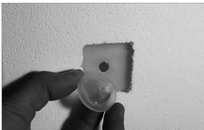
5. Pokryć płyty z tworzywa sztucznego klejem do PP za pomocą pistoletu do kleju topliwego (podwójna wielkość otworu). Należy używać jedynie oryginalnych klei do PP i nie mieszać ich z pozostałymi!
