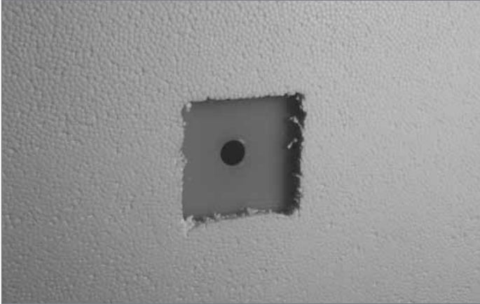
1. Beschädigte Stelle freilegen
