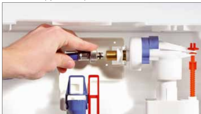
Соединение шланга с металлической оплеткой с заливным клапаном
