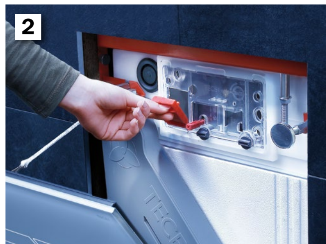
2 Klep open: de inworpschacht voor reinigingstabletten in het inbouwreservoir is goed toegankelijk.
