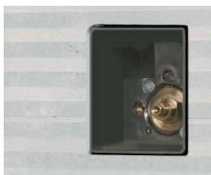
Il sistema di protezione in materiale plastico evita che l'acqua si infiltri all'interno della parete.
