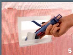
5 Dopo aver rimosso il fermo valvola, piegare le leve di azionamento scarico verso l'apertura.
