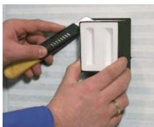
Nella fase d'installazione il sistema di protezione viene tagliato a filo con le piastrelle.
