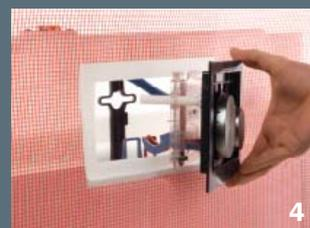
4 In caso di manutenzione l'intera piastra di montaggio è rimovibile completamente, mantenendo comunque tutte le impostazioni.
