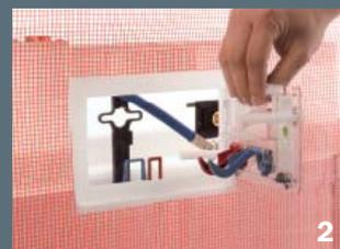
2 La piastra di comando è una unità compatta composta dal coperchio di protezione spruzzi, leverismi di azionamento e sistema di bloccaggio.
