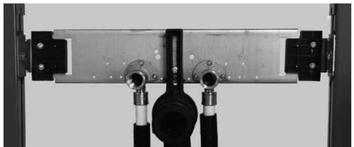
Schallentkopplung der Traverse vom Modulrahmen
