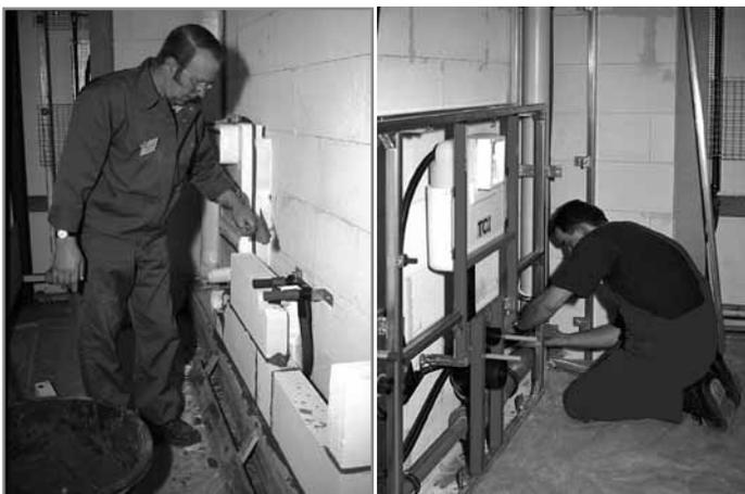
Nassbau (links) gegen Trockenbau
