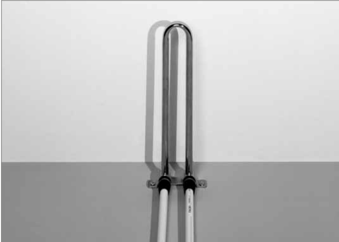
Heizkörperanschluss mit HK-Montagegarnitur, Bodenmontage – bereit zum Abdrücken
