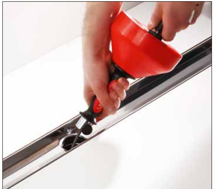
Abflussleitung mit kleiner Handspirale säubern
