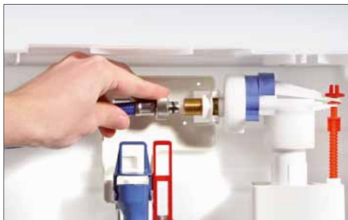
Anschluss des Panzerschlauches am Füllventil
