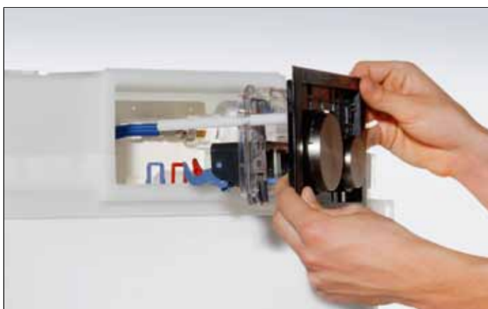
Demontage der Betätigungseinheit
