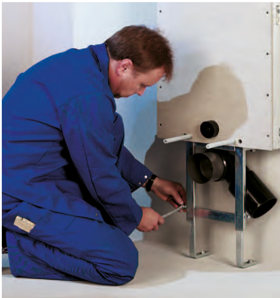
Einfache Montage: Standfüsse und Befestigungswinkel sind variabel.
