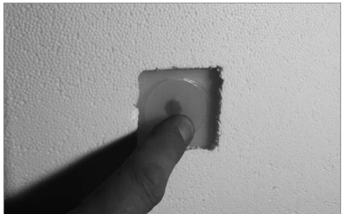
6. Sofort Kunststoffscheibe mit Klebeseite auf den Spülkasten aufsetzen und kurz andrücken
