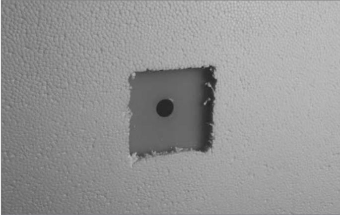
1. Beschädigte Stelle freilegen
