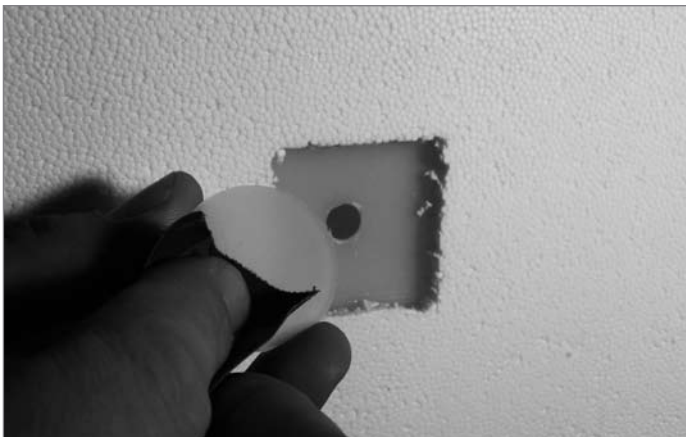
3. Passare la carta vetrata intorno al foro e sul dischetto
