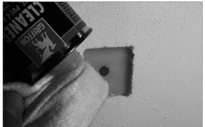
4. Pulire le zone da incollare con un solvente (anche acetone)
