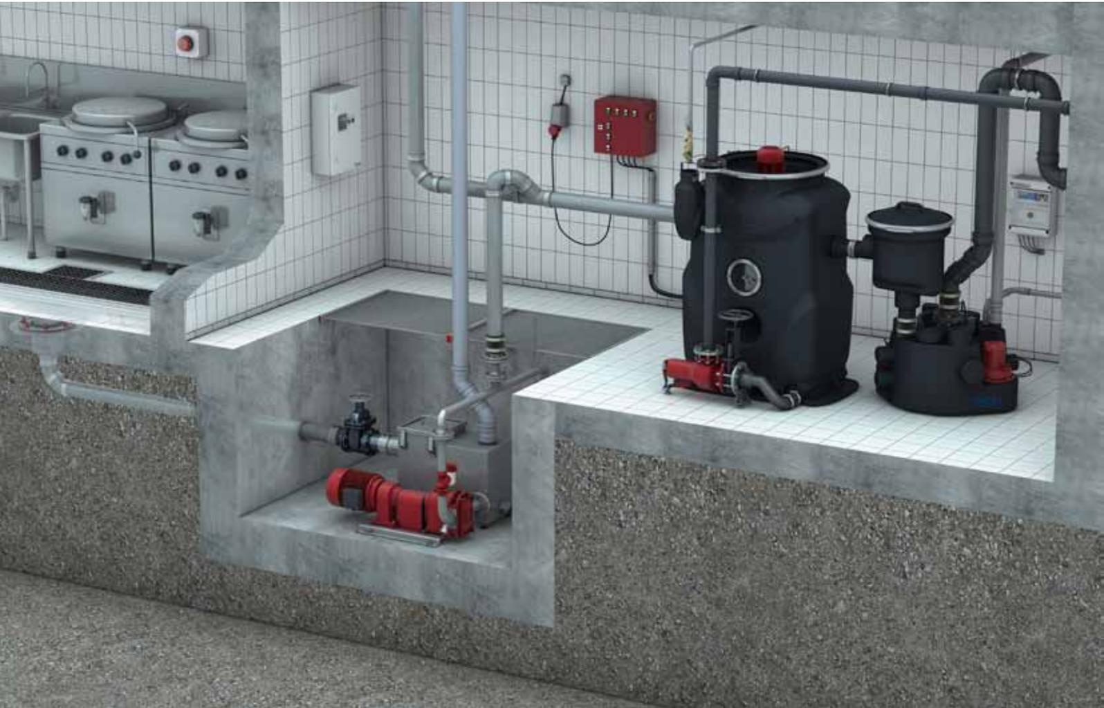
Wenn Abwässer aus der Küche nicht auf dem normalen Weg in den Fettabscheider zurückgeführt werden können, sind Drehkolbenpumpen-Hebeanlagen die Lösung.
